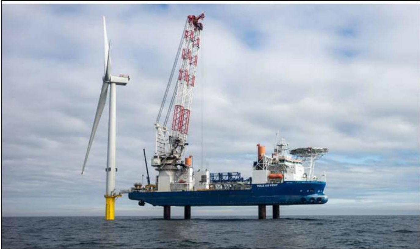
De kraan van het offshore jack-up installatieschip Vole au Vent (Jan De Nul) laat toe om op een veilige manier zware funderingen en componenten van offshore windmolenparken te installeren. © Haven Oostende
